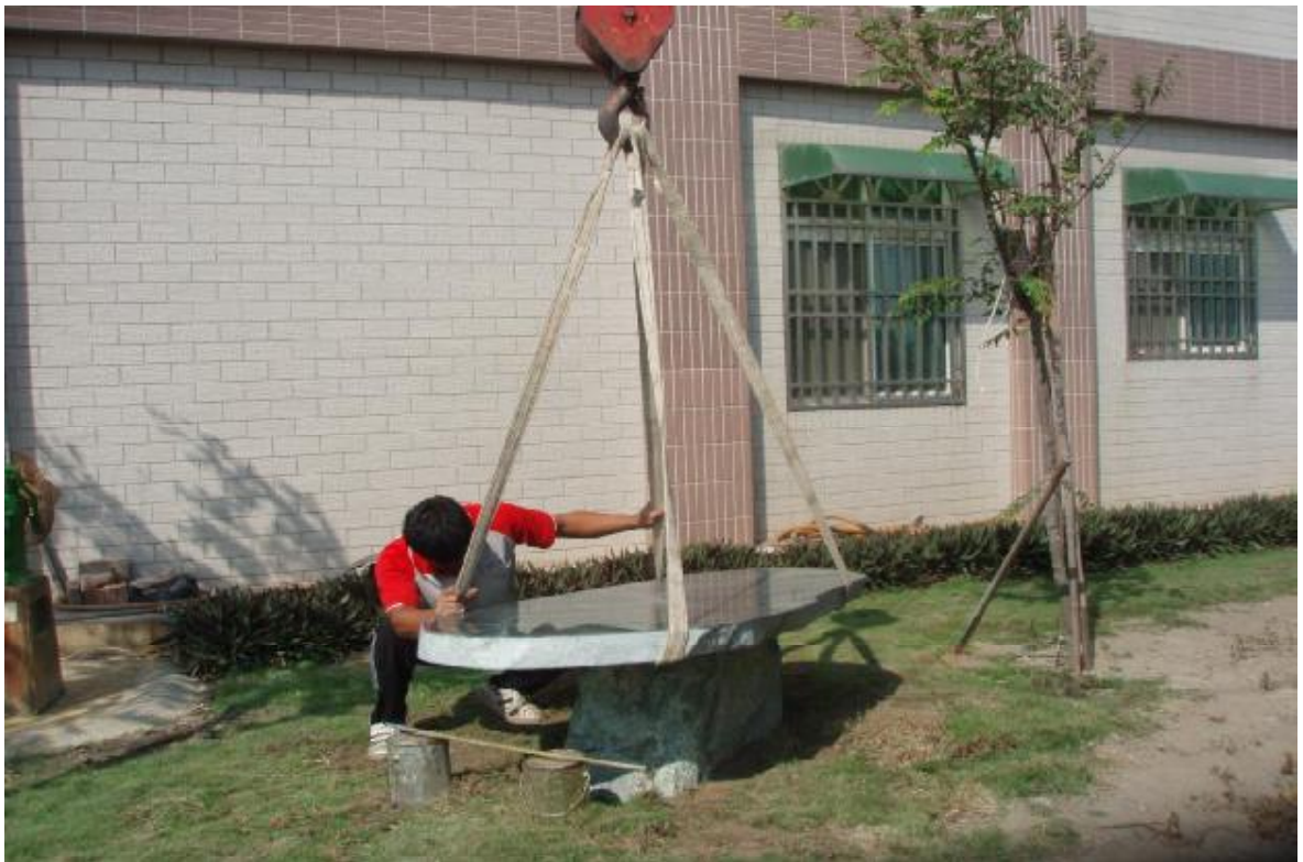
石桌椅施工中
