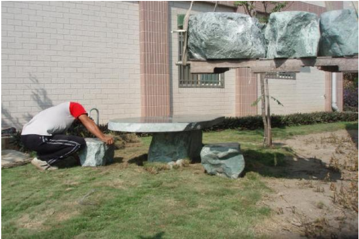
石桌椅施工中
