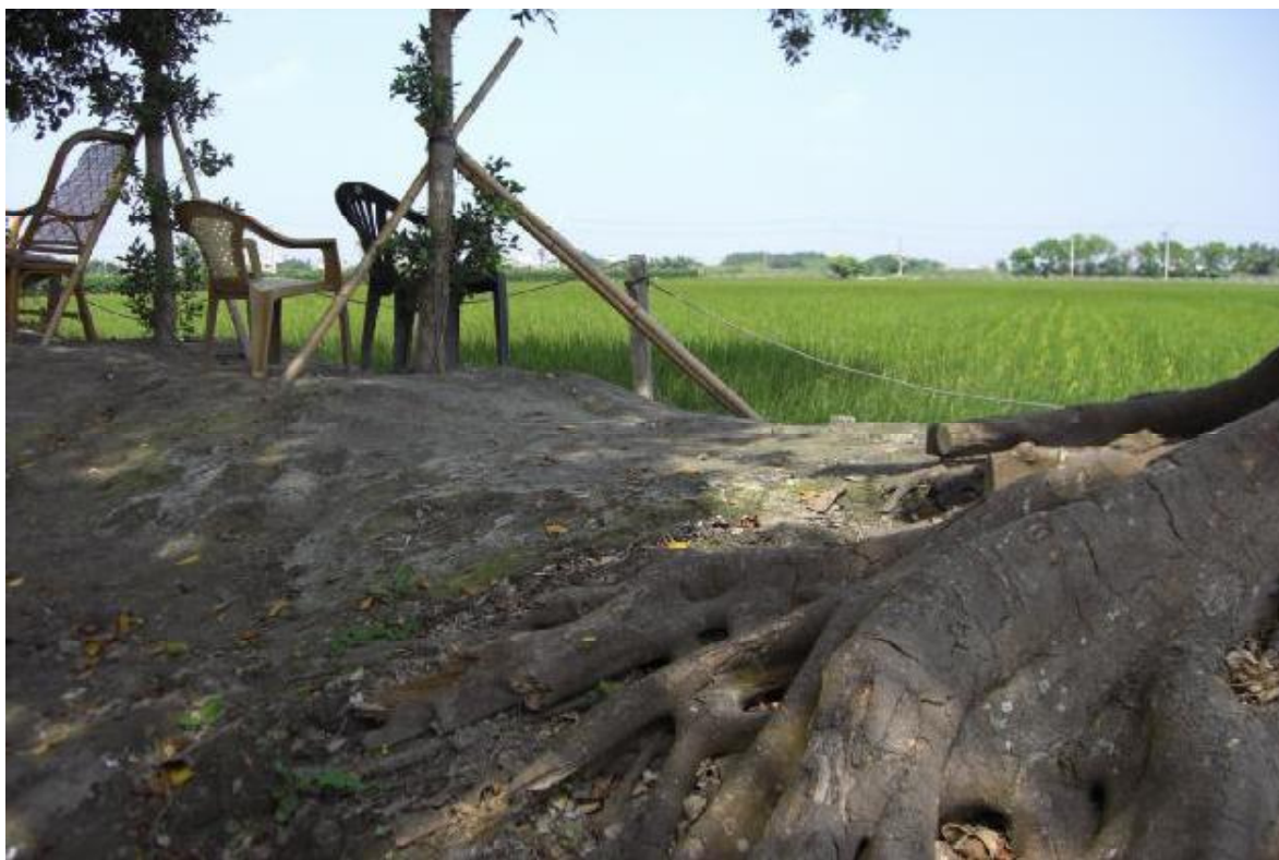
石桌椅施工前
