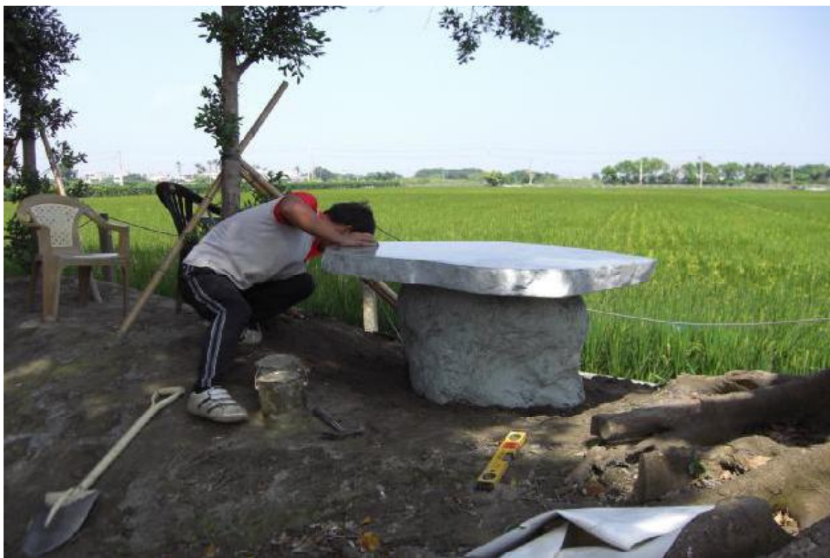
石桌椅施工中
