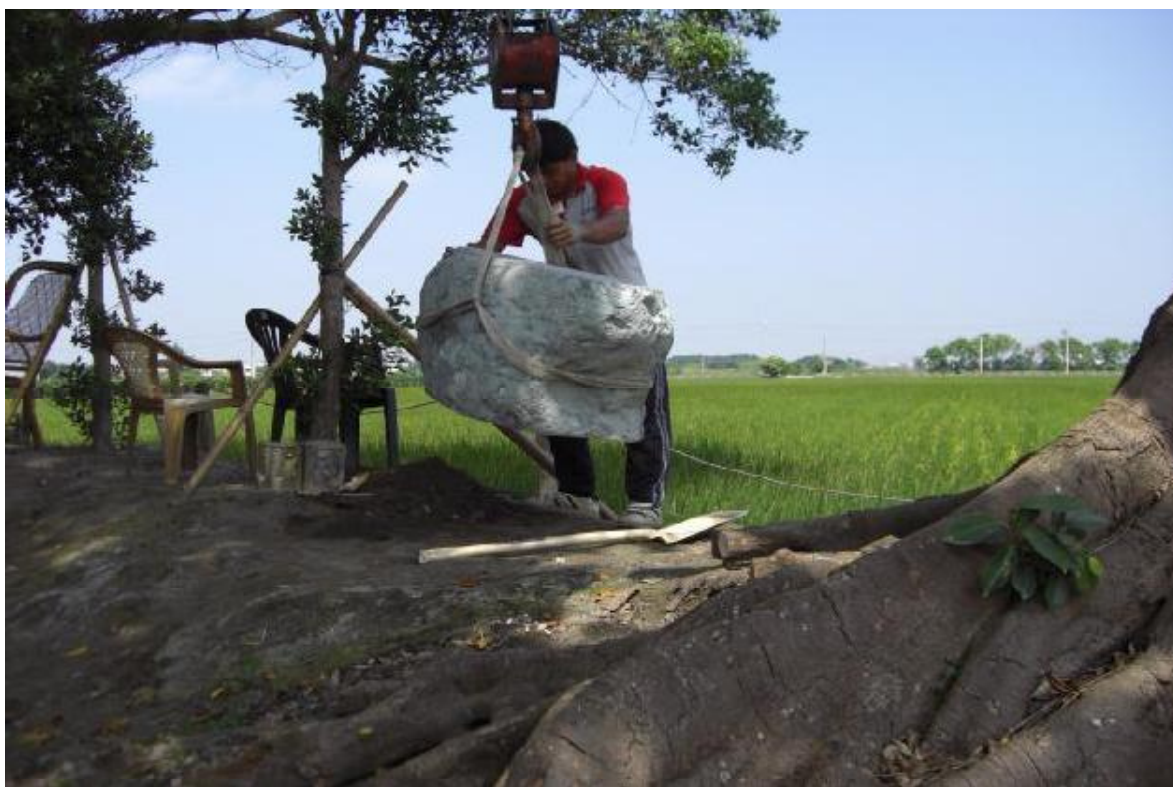
石桌椅施工中
